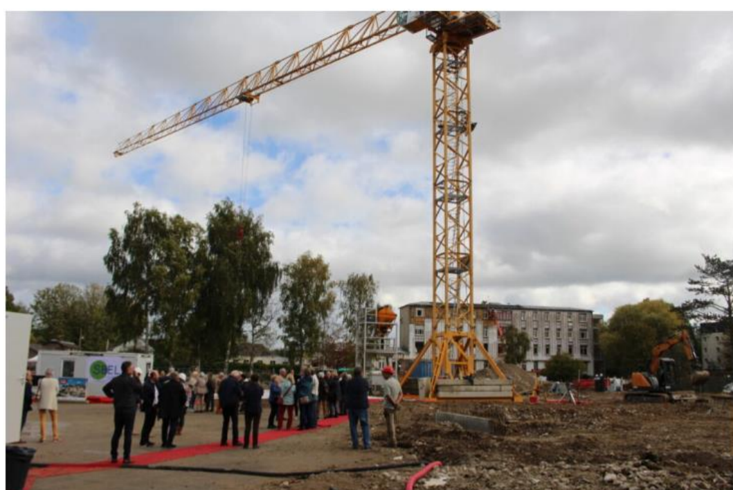
Fonta a déroulé le tapis rouge pour ses partenaires et futurs clients de la résidence Les Jardins de Ponti sur le site de l'ancien hôpital. Le bâtiment Bossard doit encore être démolir pour la deuxième tranche de travaux. ©Camille RUFFRAY / Le Pays d'Auge
